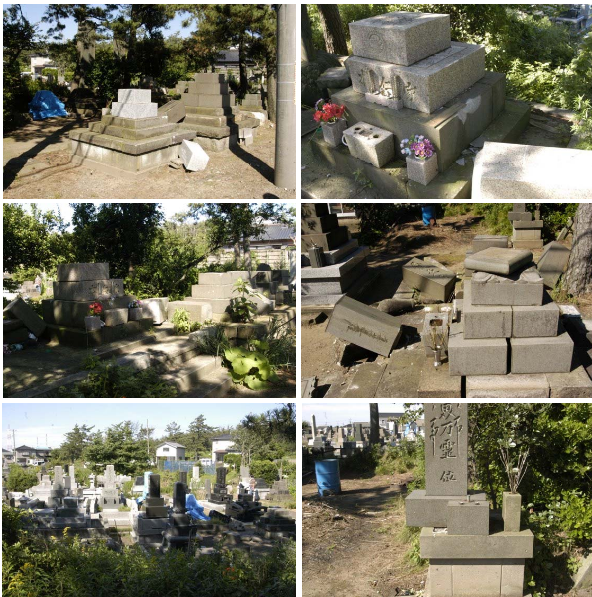
第 11 図 柏崎市荒浜の蓮華寺墓地の墓石損傷状態 谷の部分では損傷は少ない(下左, 下右の奥)のに対して, 道路沿いの高い部分では被害が大きい. 東南東もしくは西北西方向に転倒しているものが多い.
