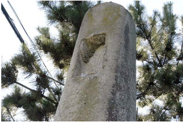
第7図 西側の柱の上部.貫の下および柱の頂部には剥離痕が認められるが、いずれも汚れていて、今回以前の傷であることがわかる。
