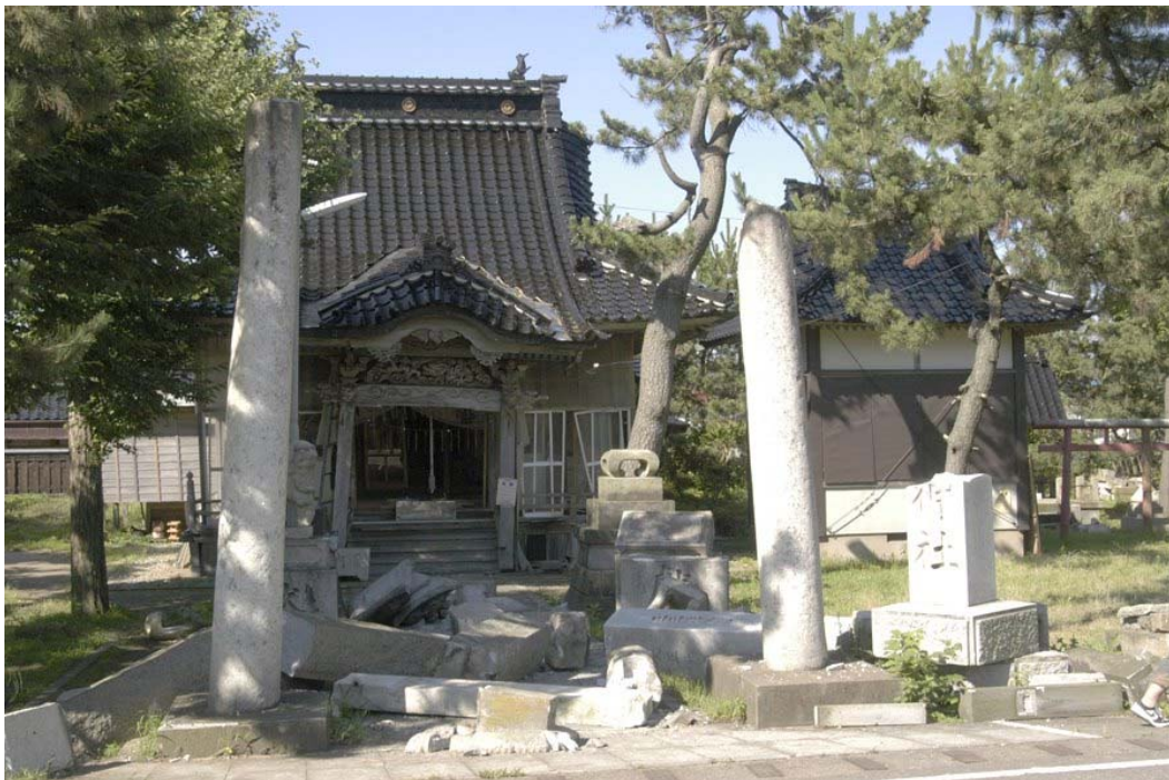
第2図 柏崎市荒浜の諏訪神社の鳥居の破損 鳥居は笠木と貫が落下し, 東北東側の柱が貫の部分から破断した. 落ちた柱より外側の貫もしくは笠木が, 隣接する石碑の頂部に当たって, 石碑は途中から折れた.
