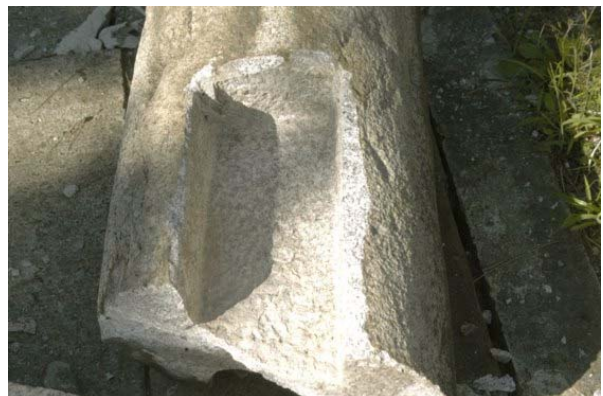
第6図 折れて落下した東側の柱の貫より上部。南側の破断面は汚れていて、今回までにひびが入っていた。
