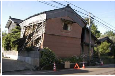
第5図 柏崎市長浜町の傾いた土蔵
