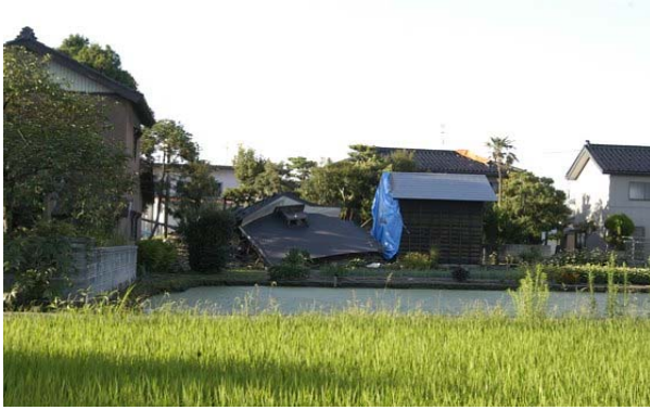
第 16 図 柏崎市北半田の微高地上の建築年代の古い建物の倒壊と、微高地と低地の境界にある溜池 水位は地震後に 20cm 弱低下したということである。
