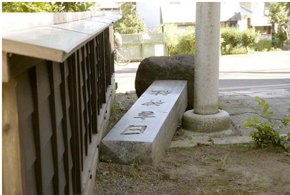
第6図 まさに神業！的転倒の柏崎市長浜町日吉神社の石碑 塀と鳥居の亀腹との約3cmの隙間に倒れた。 http://kei.kj.yamagata-u.ac.jp/kawabe/www/torii/
