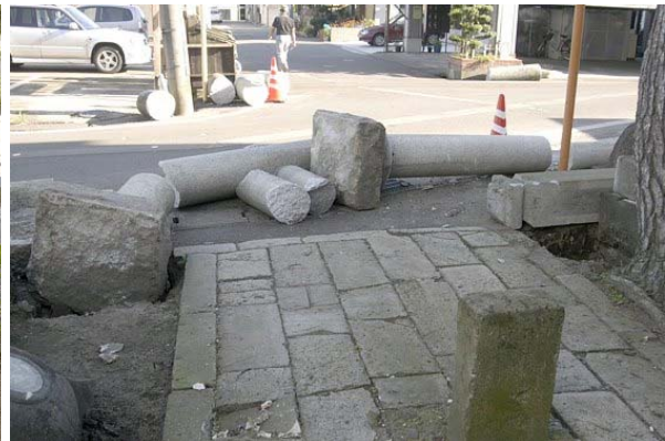
第7図 柏崎市比角1丁目の羽森神社の倒壊した鳥居基礎が抜けて転倒した。
