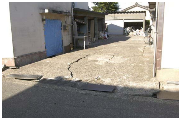
第 14 図 柏崎市四谷 2 丁目 1 の斜面方向の道路沿いに見られる斜面下部の盛り上がり。
