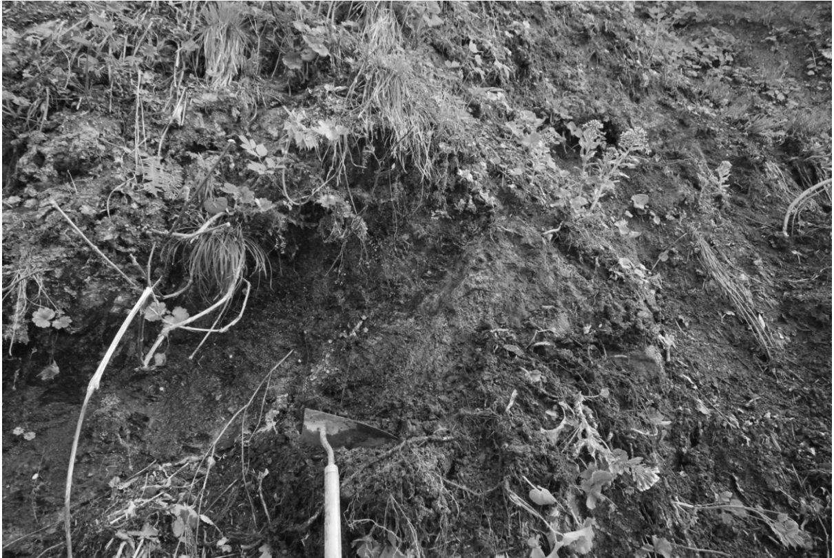
第6図 関川沿い（第5図-b）にみられる，火山岩類を切る断層破碎帯中の断層．
